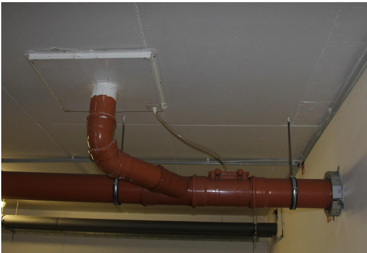
Obr. č. 10 – Takto to vypadá v reálném osazení ve spodní stavbě
