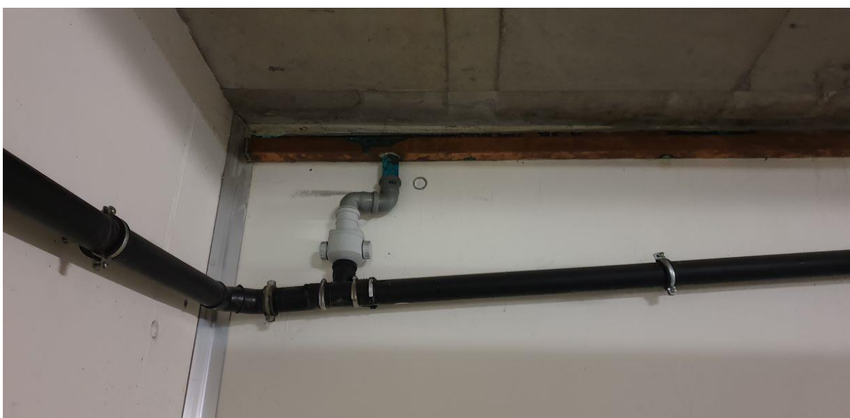
Obr. č. 7 – Odvodnění svodného žlábků do kanalizace
